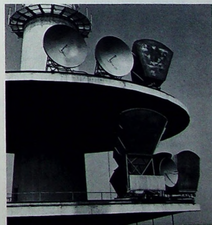
Bild 4. Verschiedene Antennenarten auf den Plattformen eines Fernmeldeturms (Werkfoto SEL)
